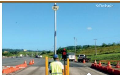
A instalação dos **scanners**, em substituição às barreiras óticas, elimina o risco de colisão de veículos com cargas laterais excedentes, além de melhorar a telemetria das pistas automáticas, promovendo maior confiabilidade ao sistema.
